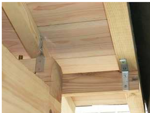
補強金具の取り付け
