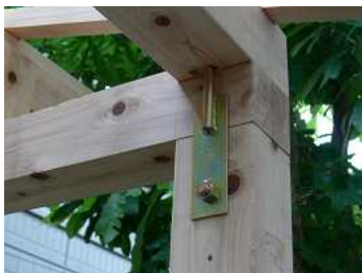
柱と桁を羽子板金具で緊結
