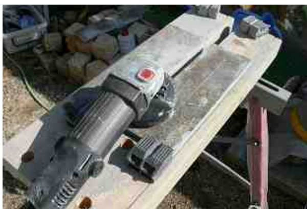
サビスレートを基礎の枠用に加工しハタガネで止めます
