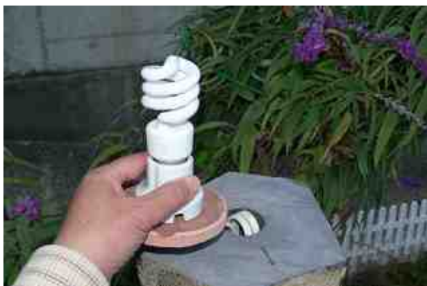
電球型蛍光灯を差し込んでホヤを被せる
