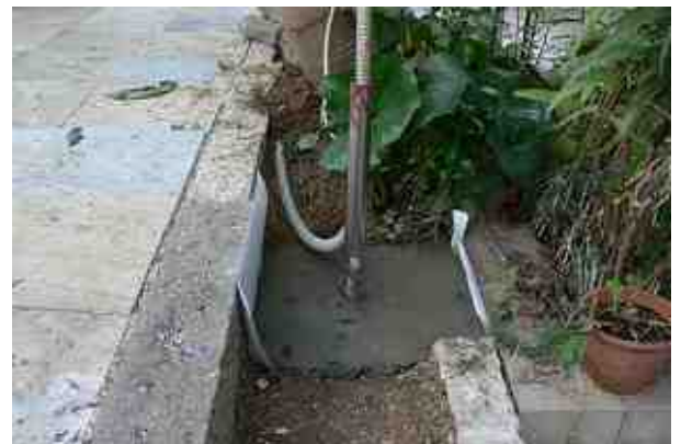
電線管を通したステンレスパイプを立てる
