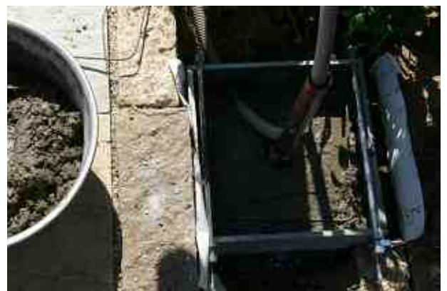
サビスレートを基礎の枠用に加工しハタガネで止めます
