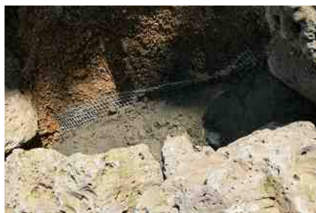
金網にモルタルの塗り込み
