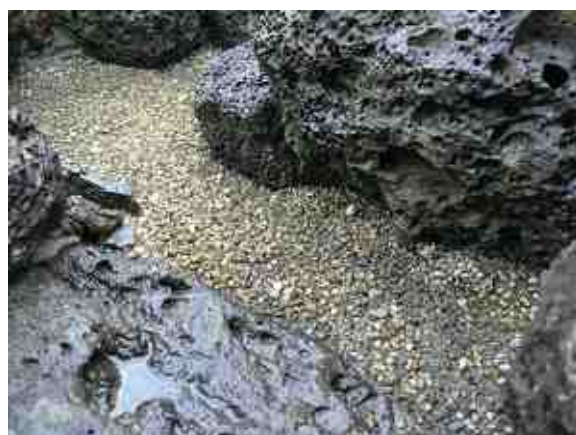
下流川底の仕上げ
