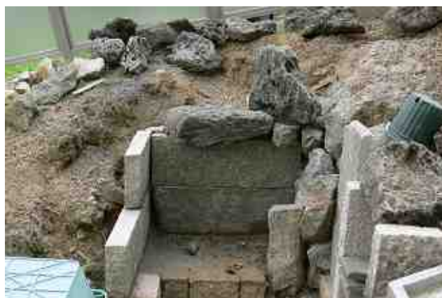
下の滝 水落ち部の取り付け
