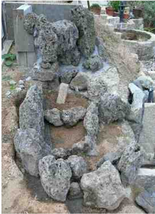
石の基礎固め状況
