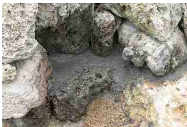
基礎部を黒いモルタルで固める
