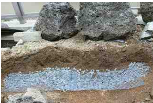
基礎砕石と金網敷きこみ
