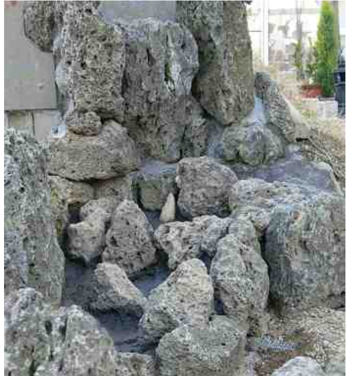
水路底へのモルタル塗り込み
