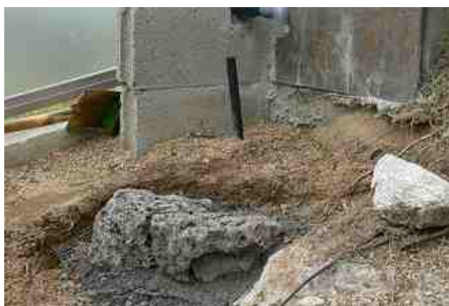
基礎となる石の据付
