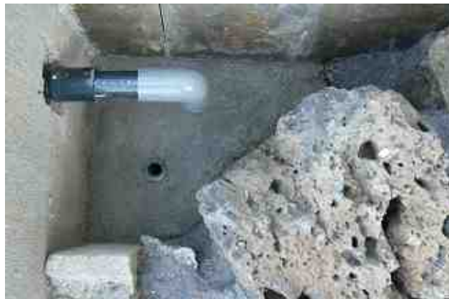
滝口ピット底の防水モルタル仕上げ
