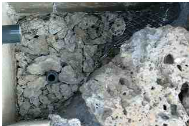
滝口ピット底の基礎碎石とラス網
