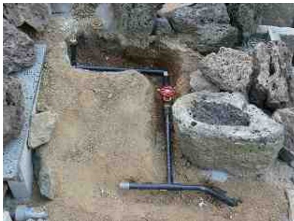
水道引込み配管
