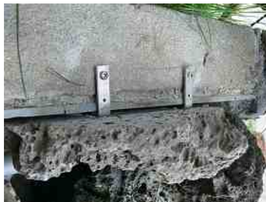
背面平らな石に矩折れ金物を付け、鉄平石の前にぶら下げる
