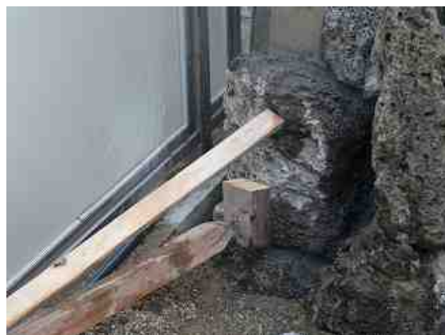
火山岩をモルタルで固定
