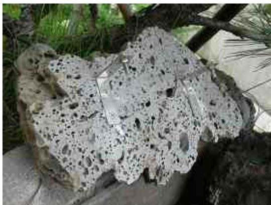
背面平らな石に矩折れ金物を付け、鉄平石の前にぶら下げる
