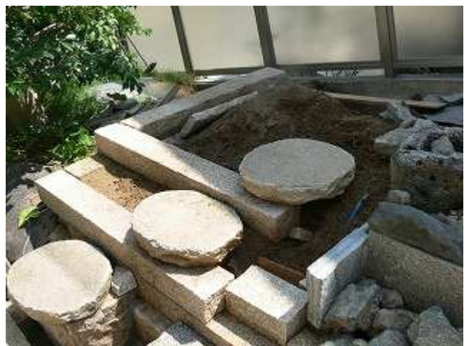
縁石用サビ御影の据付け
