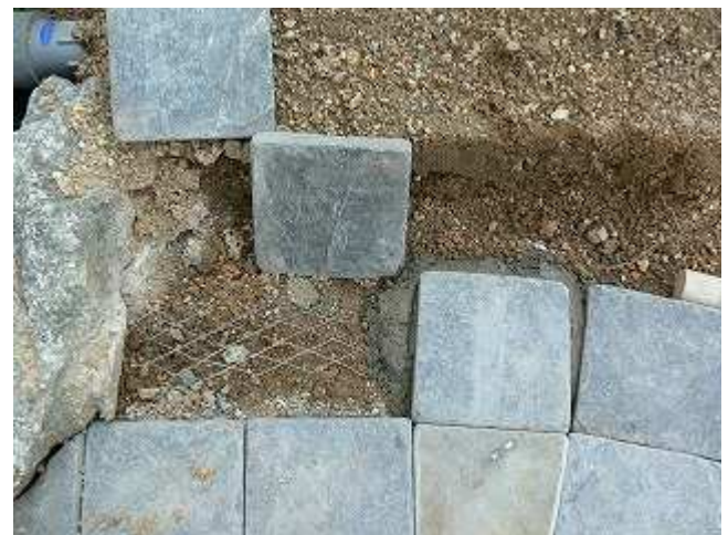
縁石の無い端部の舗石の施工
