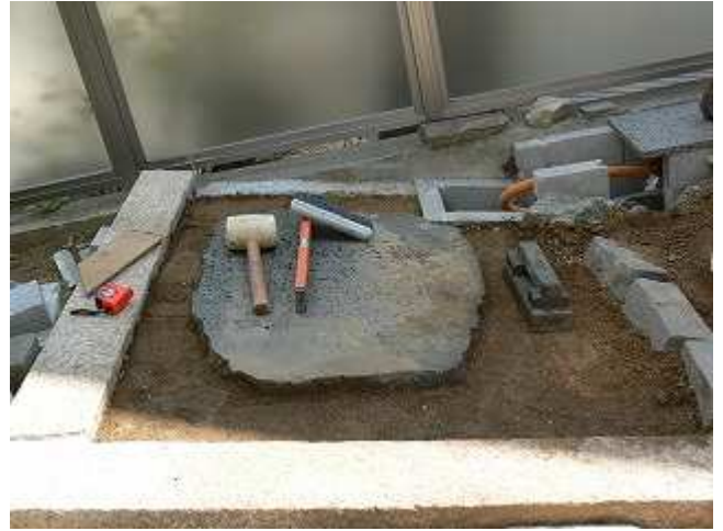
舗石を敷くための下地造り
