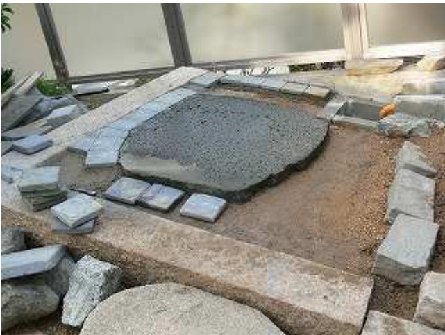
舗石の敷均し
