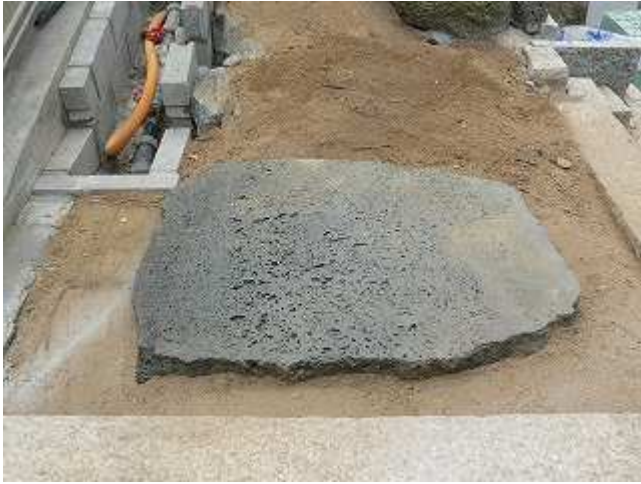
座禅石（火山岩）の据付け
