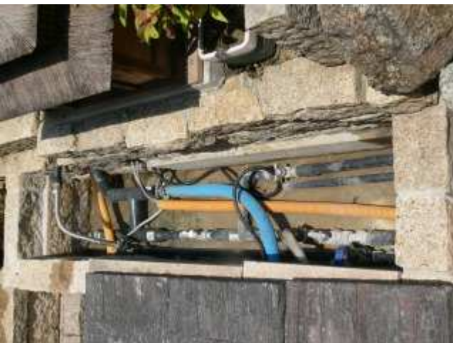
（左）配管トラフ内の配管・配線、（右）配管トラフに蓋をした状態
