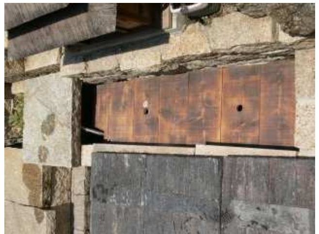
（左）配管トラフ内の配管・配線、（右）配管トラフに蓋をした状態
