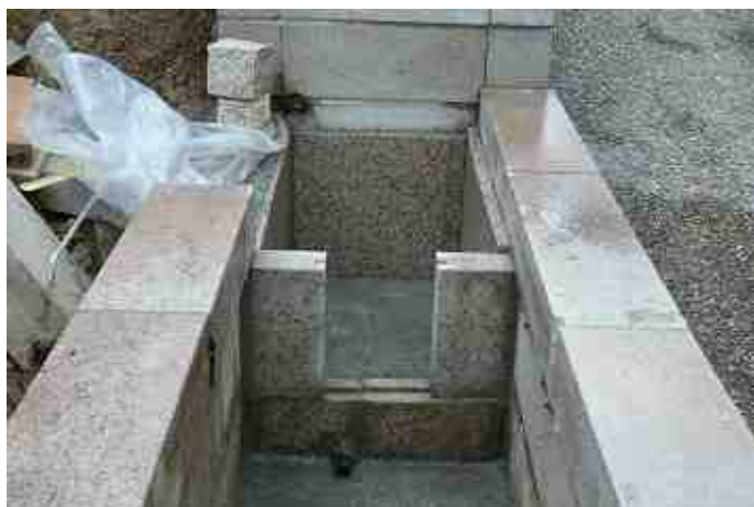
手前がポンプ室・向う側が貯水槽
