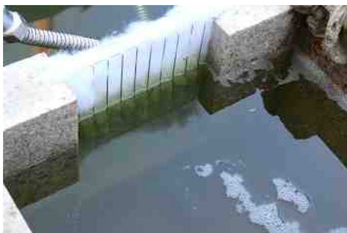
ろ過材の取付け
