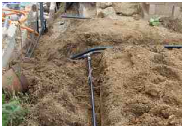
塩ビ配管の曲げ加工
