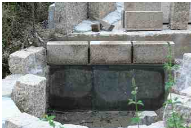
滝2 の越流部施工
