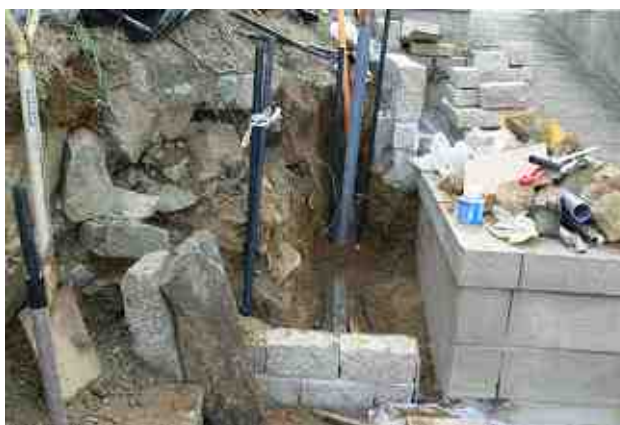
開渠部へ続く配管
