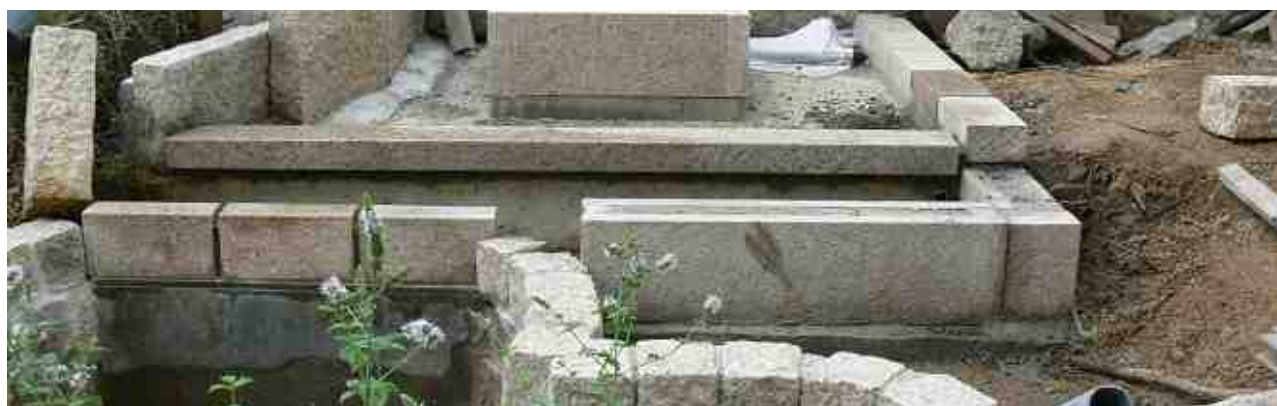
越流部の施工
