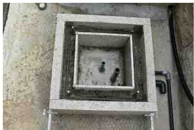
隔室部製作状況
