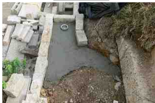
開水路部施工
