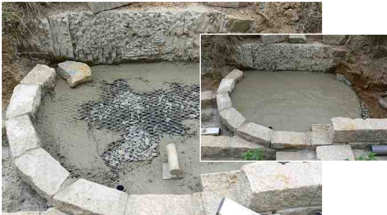
池底の防水モルタル施工
