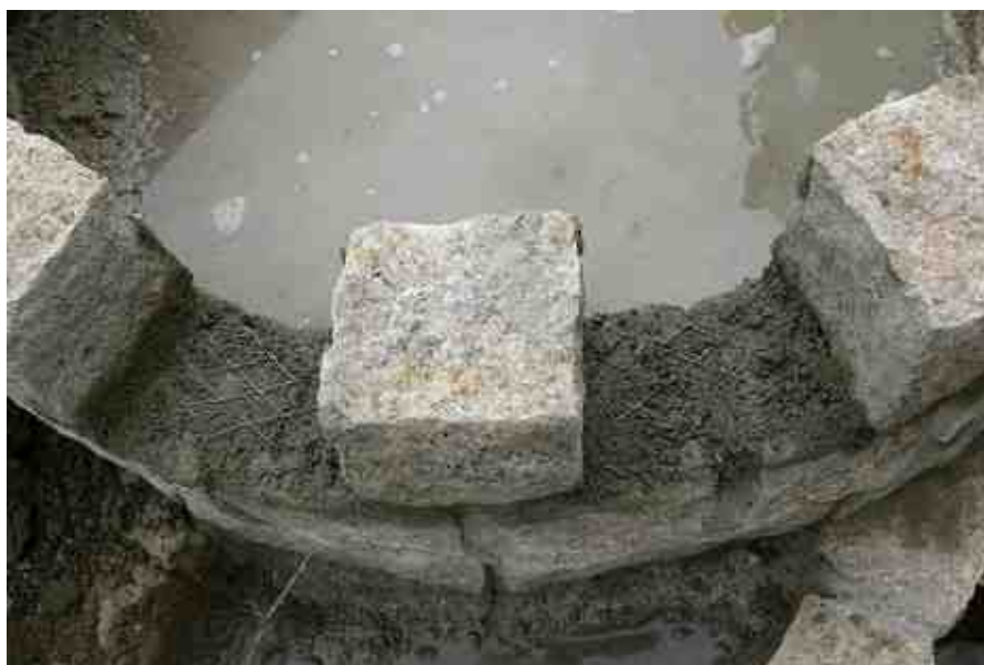
横目地にラスを入れる
