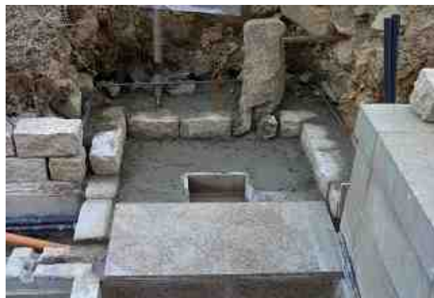
下噴水の基礎部
