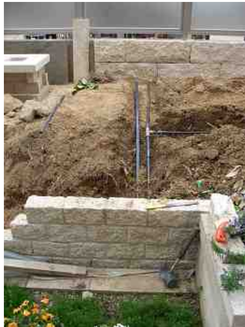
給水管と水道管との接続
